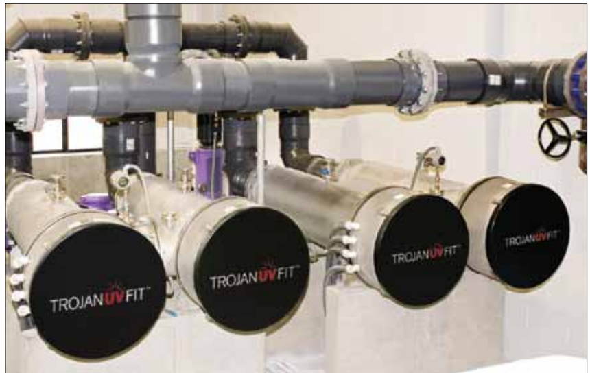
I reattori possono essere installati in parallelo o in serie, per una maggior flessibilità del design e dell'installazione.
